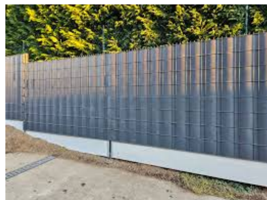
Stínící pás do plotových panelů (bude pouze 1xpole u terasy) Odstín antracit kód 22011 Umístění dle samostatného výkresu
