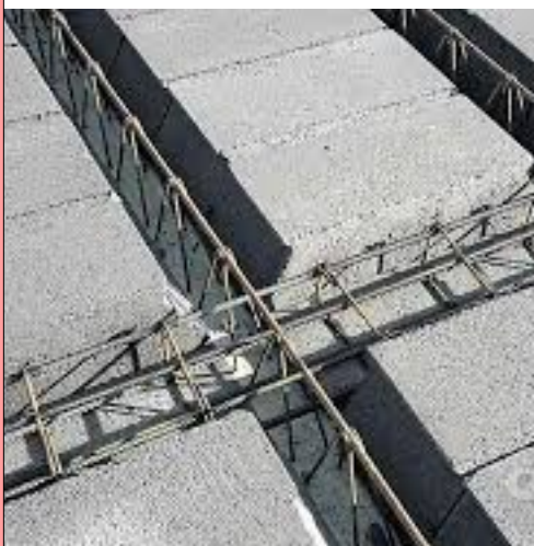
Stropní konstrukce Trámečkový skládaný strop LiveTherm BSG
